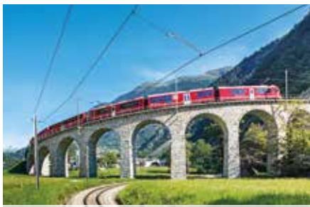
Bernina-Express im Kreis-Viadukt von Brusio
